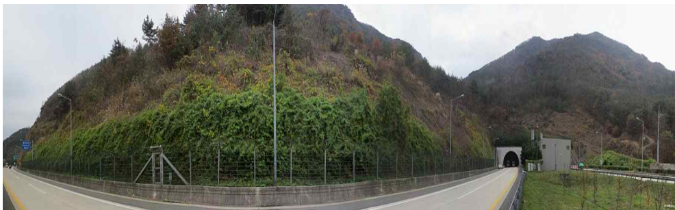
(중점부 절토사면 전경)
