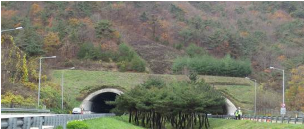
(시점부 절토사면 전경)
